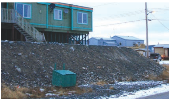
Une épaisse couche de gravier aide à préserver le pergélisol.
