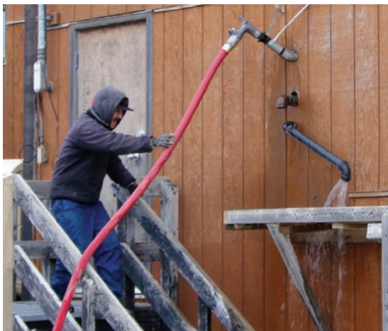
Un débordement de votre réservoir d'eau peut provoquer le dégel du pergélisol.
