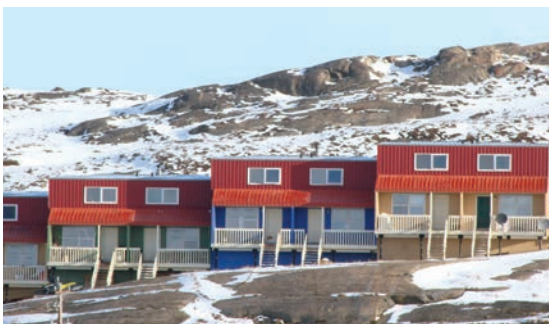
Le propriétaire d'une habitation construite sur un substrat rocheux n'a pas à se soucier outre mesure de la fonte du pergélisol.
