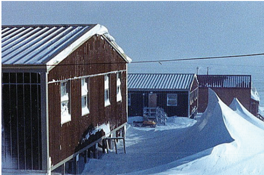
Cette congère est suffisamment loin de la maison pour ne pas affecter le pergélisol. Source : RWDI inc.
