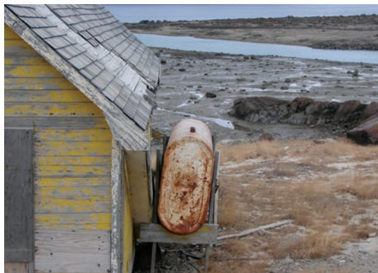
Un réservoir bancal ou incliné peut provoquer une rupture dans votre conduite de mazout domestique.
